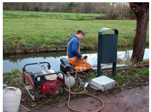
Gerben van aannemer De Vries legt de laatste hand aan een overstort van het hemelwaterriool aan de Nachtegaallaan: het plaatsen van een nieuwe afsluiter
