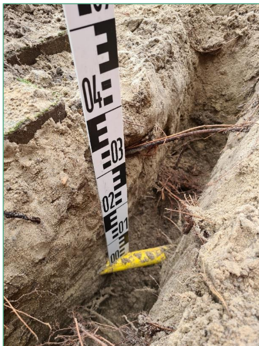
Afbeelding 3.13; Aangetroffen gasleiding in verplantkluft Afbeelding 3.14; Grove beworteling
